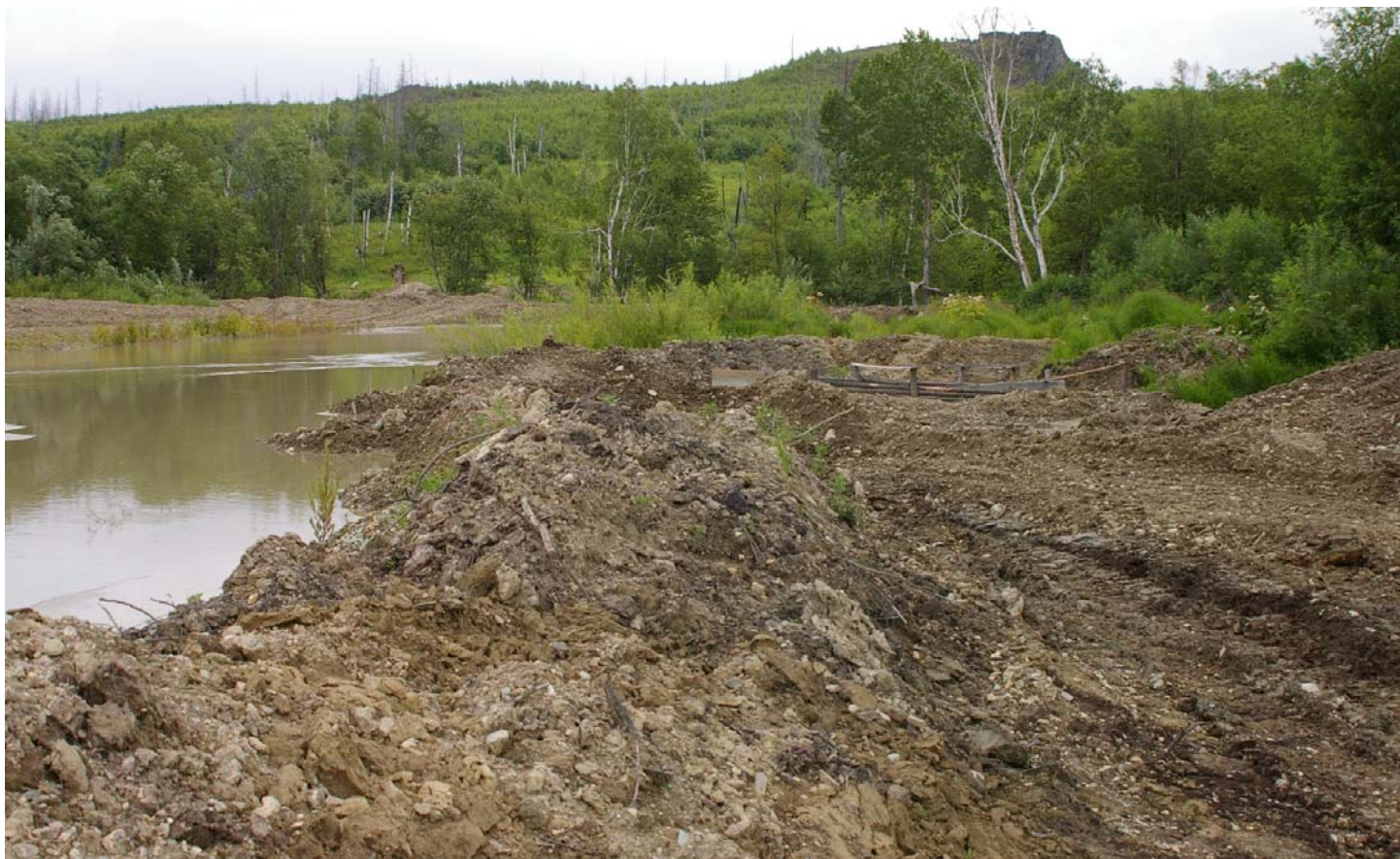
Общий вид пруда-отстойника в районе выпуска сточных вод (виден справа от центра снимка). За ним виден участок с отсутствующей обваловкой.
