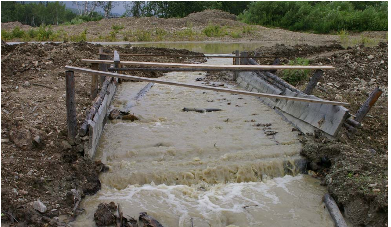
Сливной лоток организованного выпуска сточных вод на р. Дербыша
