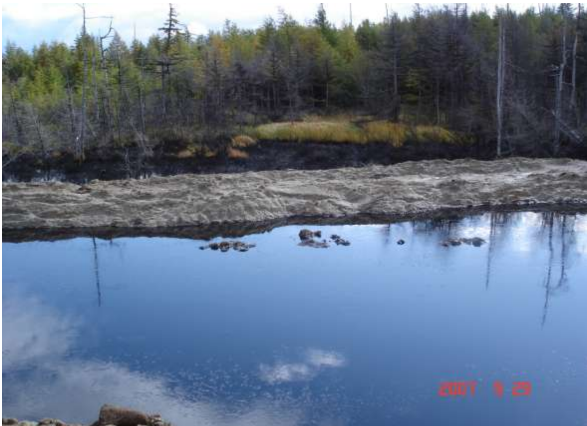
Нефтепромысел "Катангли", нефтеловушка № 5. Нефть на переднем плане находится внутри обваловки – на территории промысла. В средней части снимка – дамба (обваловка) из песчаного грунта. На заднем плане – нефтяной разлив за пределами дамбы (обваловки) .
