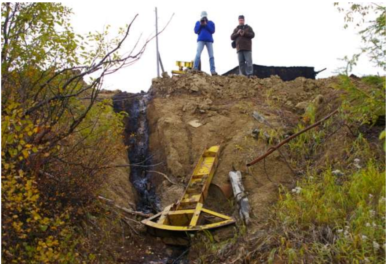
Общей вид разлива нефти возле скважины № 620 на промысле "Катангли". Поток нефти сошел вниз по залесенному склону в левой части снимка.
