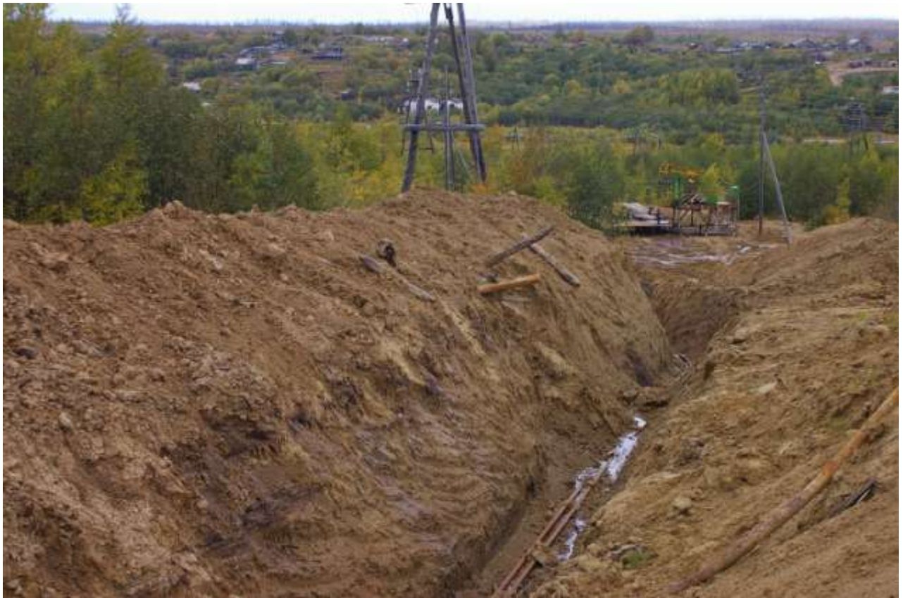
Вскрытый подземный внутрипромысловый нефтепровод, ведущий к скважине № 620.
