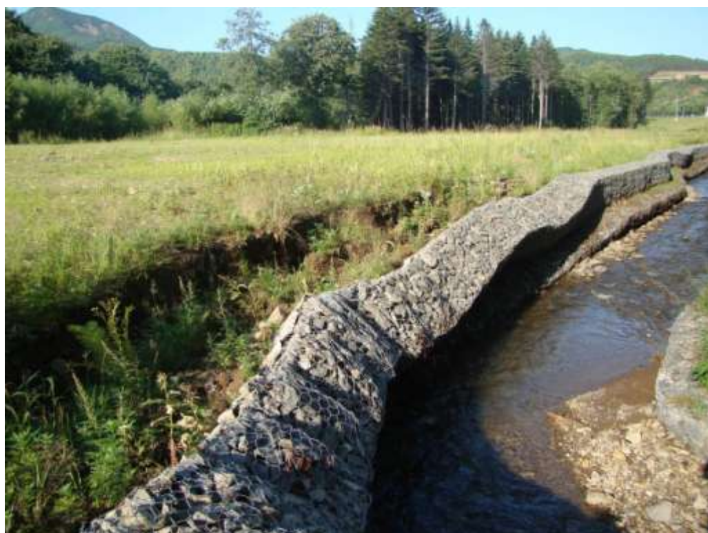
Рис.4. Река Солянка (басс. р. Макарова) после прохождения циклона 21-22 августа 2009 г. Габрион продолжает отседать от борта и заваливаться в русло.
